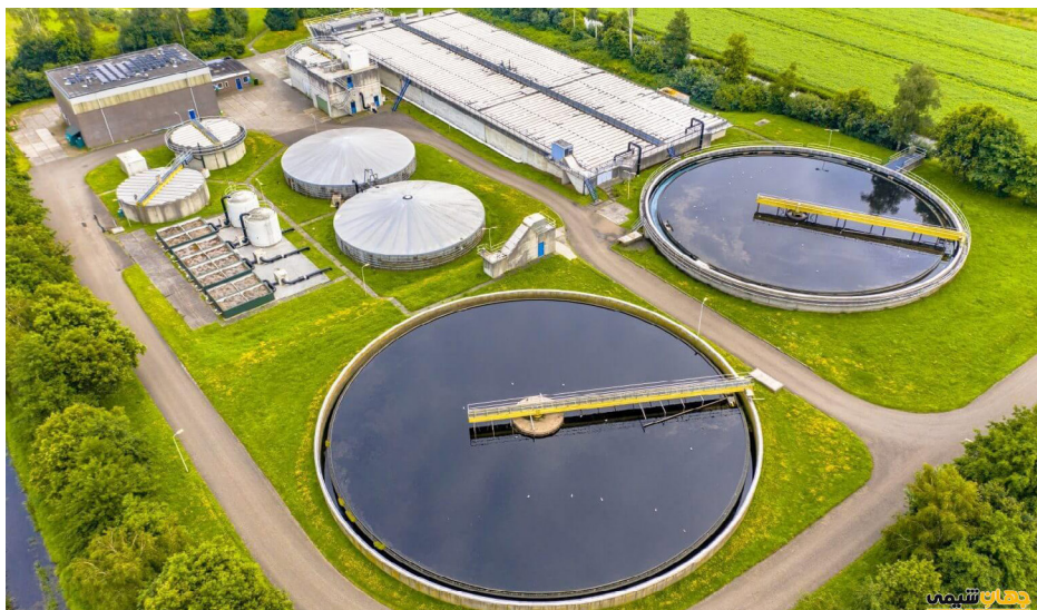
شکل ۲- موقعیت حوضچه هوا دهی، ته نشینی و مخزن لجن مازاد
