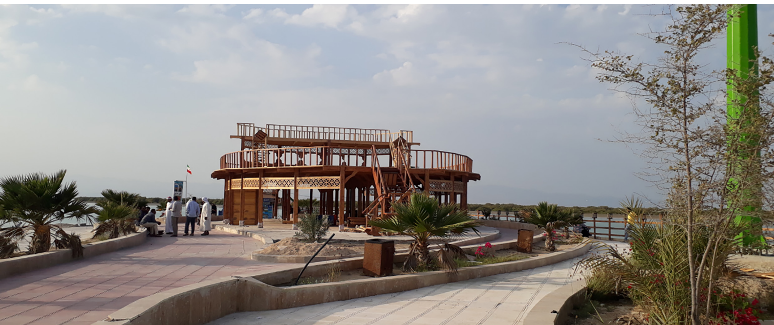
شکل ۱۶- اسکله تفریحی طبل
