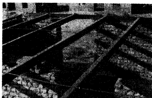
تصویر شماره ۲۵. نحوه تیرریزی سقف ساختمان‌ها
