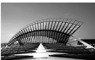
تصویر شماره ۱۶- نمونه‌ای از فرم‌های بدیع در معماری و سازه با استفاده از شکل اسکلت حیوانات، ساختمان ورودی ترمینال فرودگاه لیون کشور فرانسه
