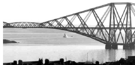
تصویر شماره ۴- پل طره ای Forth در اسکاتلند
