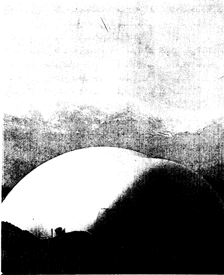
۱. خانه پوسته‌ای بتنی که با استفاده از قالب متکی بر هوا در ایالت کُلرادو آمریکا ساخته شده است.
