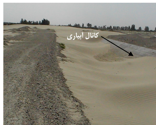
شکل ۳. پر شدن کانال‌های آبیاری سیمانی به طول چندین کیلومتر که بر اثر انباشت شن و ماسه غیرقابل استفاده شده‌اند
