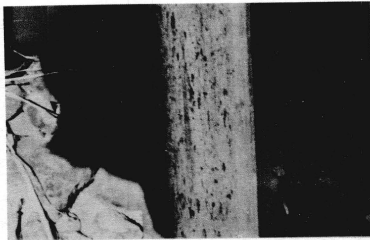
شکل ۱ - معایب ریل راه آهن در نزدیکی ایستگاه سمنان
