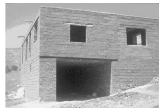
تصویر ۱۱ - استفاده از مصالح جدید نظیر بلوک های سیمانی، (مآخذ: نگارندگان)
