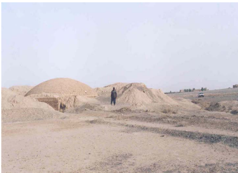
تصویر شماره ۷: وضعیت امروزی آب انبار کاروانسرای نوگنبد؛ محل ذخیره آب قنات اریکا(؟) محصور در شن‌های روان
