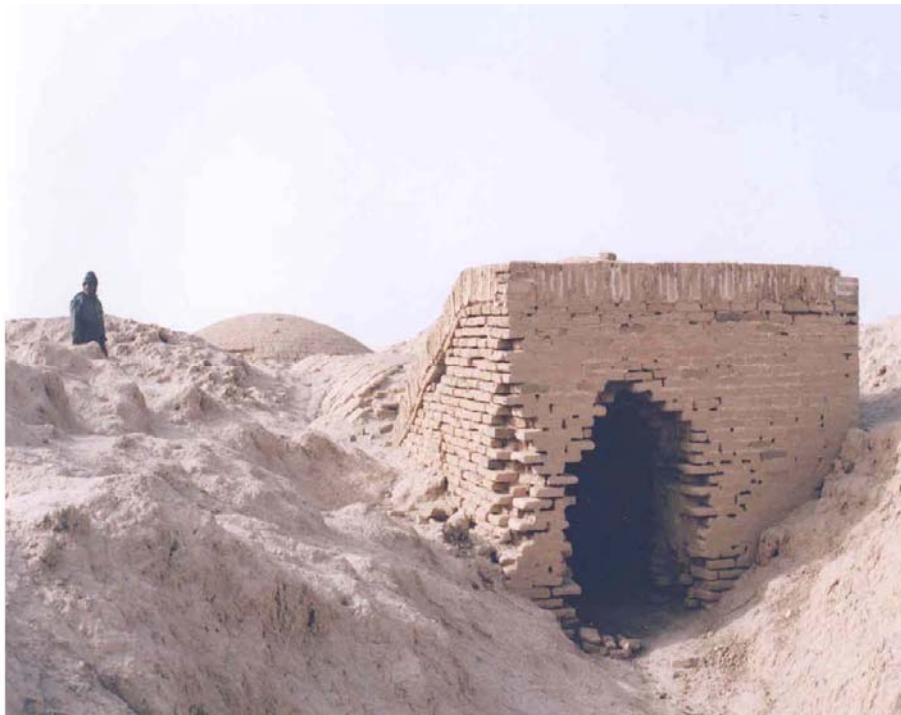
تصویر شماره ۹: نمای ورودی آب انبار کاروانسرای نوگنبد؛ محصور در شن‌های روان
