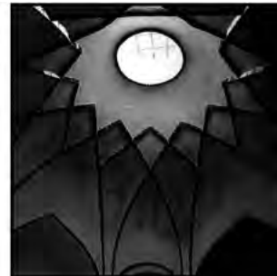
تصویر ۱۶- ترکیب دو کاربندی رسمی. \{n/d\} = \{12/5\} خانه شماره E5 نوع زمینه: هشت و نیم هشت سرپینه اقلیتها حمام چهار فصل اراک • ماخذ: گنج نامه جلد ۱۸ •• ماخذ: گنج نامه جلد ۱۸ ••• ترسیم: نگارندگان
