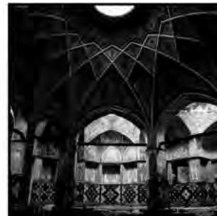
تصویر ۱۷- ترکیب دو کاربندی رسمی. \{n/d\} = \{14/5\} خانه شماره F5 نوع زمینه: هشت ضلعی خاص سرپینه حمام سلطان میر احمد کاشان • ماخذ: گنج نامه جلد ۱۸ •• ماخذ: گنج نامه جلد ۱۸ ••• ترسیم: نگارندگان
