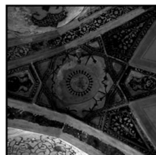
تصویر ۱۹- کاربندی رسمی خاص. \{n/d\} = \{12/3\} خانه شماره C3 نوع زمینه: خاص فضای سرپینه در حمام وکیل شیراز • ترسیم: نگارندگان •• ماخذ: گنج نامه جلد ۱۸ ••• ترسیم: نگارندگان
