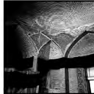
تصویر ۸- کاربندی رسمی منفرد دو پا. \{n/d\} = \{12/2\} خانه شماره E۲ ۱۲ نوع زمینه: مربع مسجد جامع شهرکرد • ماخذ: گنج نامه جلد ۸ •• ماخذ: گنج نامه جلد ۸ ••• ترسیم: نگارندگان
