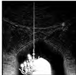
تصویر ۲۱- کاربردی رسمی خاص. \{n/d\} = \{15/3\} نوع زمینه: پنج ضلعی گنبد خانه بقعه بابا رکن الدین اصفهان • ترسیم: نگارندگان •• ماخذ: گنج نامه جلد ۱۱ ••• ترسیم: نگارندگان
