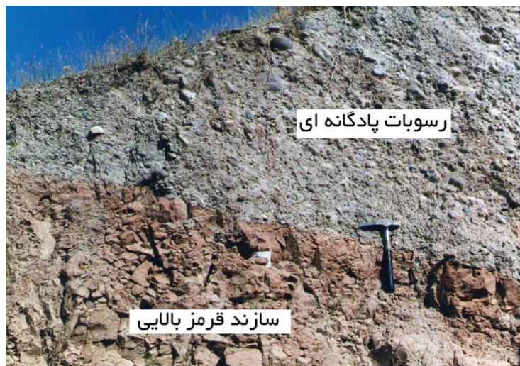
شکل ۶. تمایل رسوبات پادگانه‌ای و سازند قرمز بالایی در اثر فعالیت تکتونیکی گسل شبستر و جنوبی میشو در اطراف روستای سفید کمر
