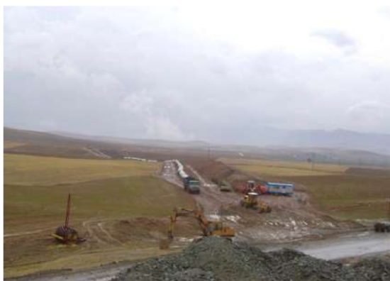
شکل ۱: حفاری کانال لوله و از بین بردن زمین‌های کشاورزی
