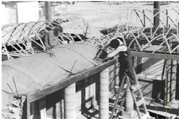
تصویر ۳- پروژه‌ی مکزیکالی: اجرای سقف با استفاده از روش‌های بومی. ماخذ: (Alexander, 2005, 554)
