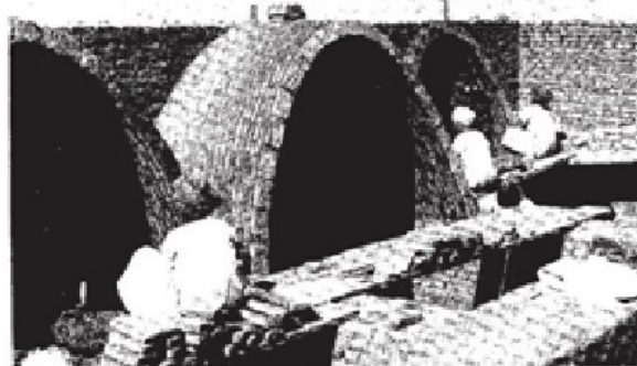
تصویر ۵- پروژه‌ی گورنای جدید؛ ساخت با استفاده مصالح بومی و توسط افراد بومی. (Serageldin, 2007, Fig18) ماخذ:
