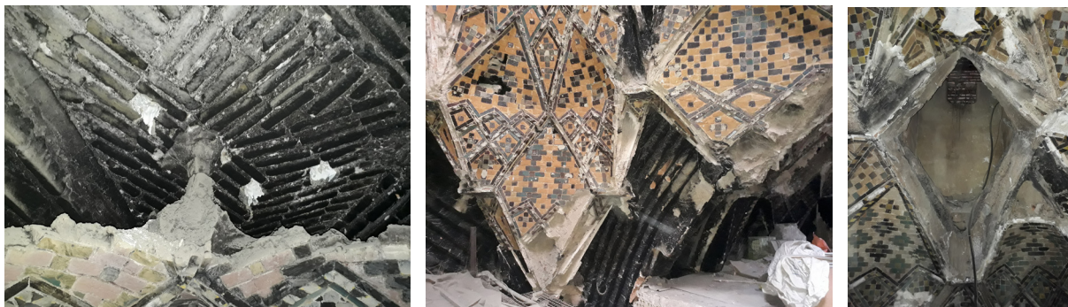
تصویر ۱۸- شیوه کلاف‌کشی، تویزه‌های باربر پنهان و طرز آویز شدن واحدهای تشکیل‌دهنده یزدی‌بندی.
