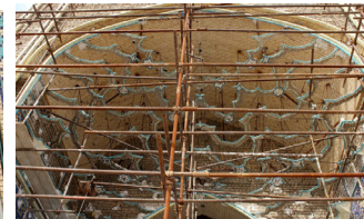
تصویر ۲۱- یک نمونه از یزدی نوع دوم. (۱): آلت سینه فخری. (۲): آلت‌های هندسی خرد شده. تصویر ۲۲- از راست: ۱. ساخت مقرنس به روش ردیف‌های معلق. ۲. یزدی بندی حجره‌های مدرسه چهارباغ اصفهان. ۳. سازه پنهان پشت ردیف‌های معلق. مآخذ: (Galdieri, 1979, 105).
