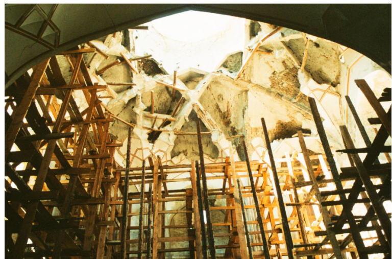
تصویر ۱۰- یزدی‌بندی پوششی بر روی لنگه تاق‌های متقاطع. ماخذ: (Hatice Yazar: Aqa Khan visual archives MIT)
