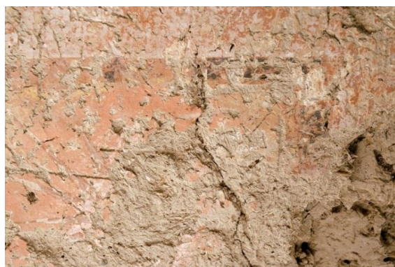
تصویر ۹- روش اجرای لایه‌های رنگی بر روی کاه‌گل در کوه خواجه زابل
