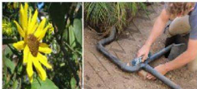
شکل ۳ یک سیستم جمع‌آوری و توزیع آب خاکستری
