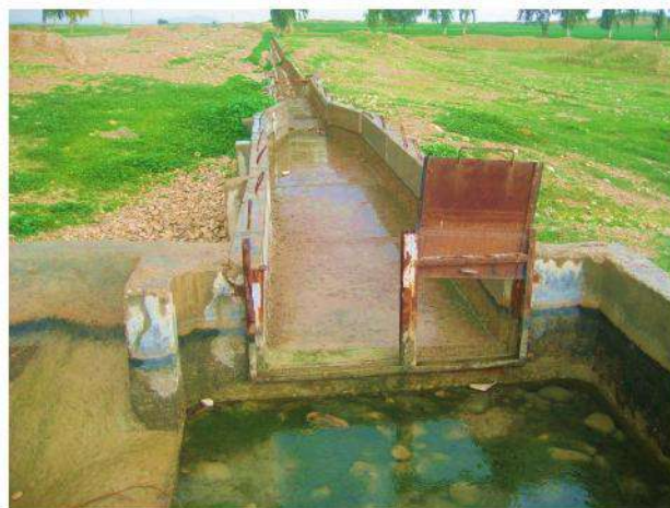
شکل ۴-۷- پاکس تقسیم آب با دریچه‌های فرسوده، شبکه آبیاری مارون
