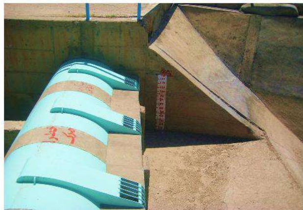
شکل ۴-۶- سرریز سیفونی، شبکه آبیاری ساوه
