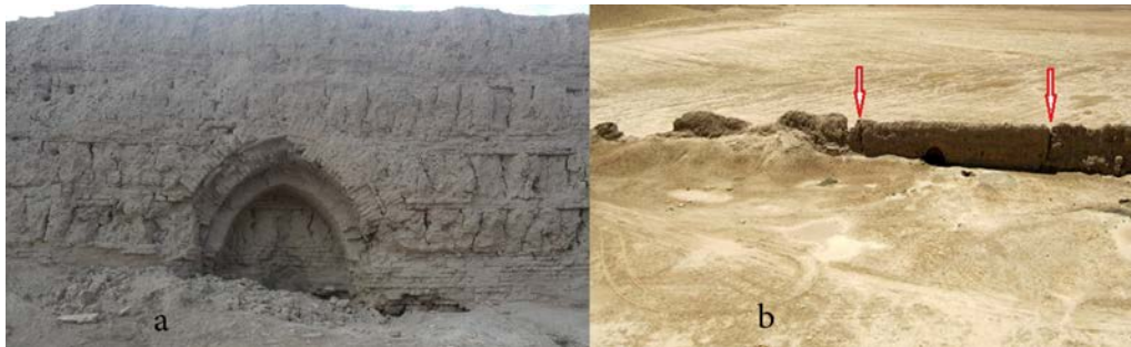
تصویر ۳- a) قوس واقع در دیوار غربی حصار بیرونی قلعه‌گلی؛ b) عدم اتصال بخش‌های مختلف دیوار جبهه غربی حصار بیرونی به یکدیگر (مأخذ: نگارندگان).
