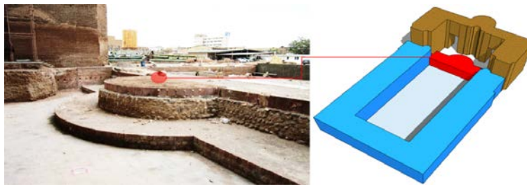
تصویر ۵- چپ: دیوار موقت با مصالح معماری کم‌ارزش (قلوه‌سنگ) جهت مسدود کردن موقت قسمت جنوبی بقایای ایلخانی شمالی؛ راست: بقایای ایلخانی (آبی) و ترکیب آن با حجم آجری U شکل جهت مسدود کردن ضلع جنوبی بقایای ایلخانی.
