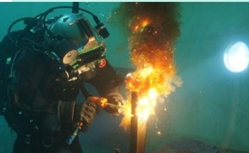
شکل ۵- انجام جوشکاری زیر آب
