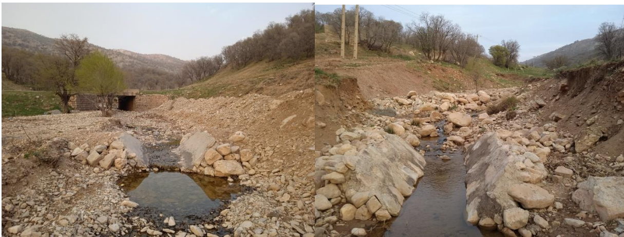
شکل ۳. کانال احداث شده در خروجی زیرحوضه جنوبی و شمالی
