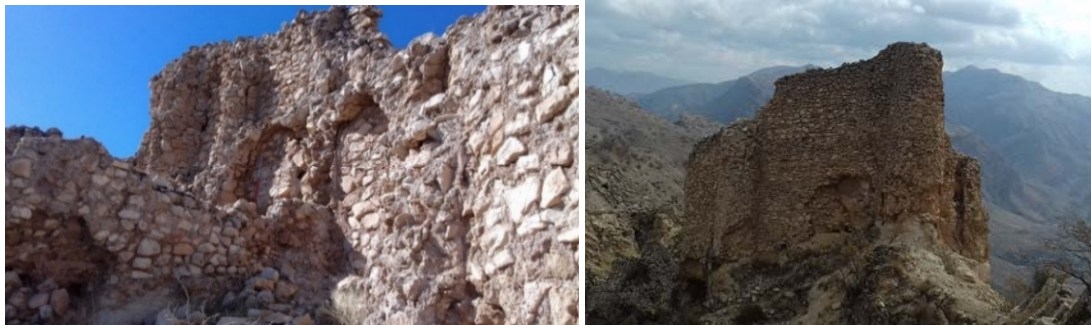
تصویر ۳. دژ قلعه‌سام (راست). نمای داخلی دیوار دژ که با طاقگان مطابق مستحکم شده است (چپ). (تصویر از نگارندگان). Figure 3. Qale-e Sam fortification (right). Interior view of the fortress wall, which reinforced with matching arches (Left side) (by the authors)
