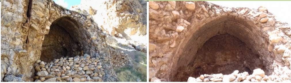
تصویر ۶. ترکیب نیم‌گنبد و ایوان در بخش شرقی مجموعه مسکونی. (تصویر از نگارندگان).
