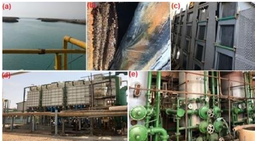
شکل ۱. نمایی از قسمت‌های مختلف تصفیه‌خانه نیروگاه بندرعباس. (a) حوضچه آبیگری، (b) فیلتر مشکی، (c) الکترولایزر، (d) دستگاه MED و (e) فیلترهای میکسید.
