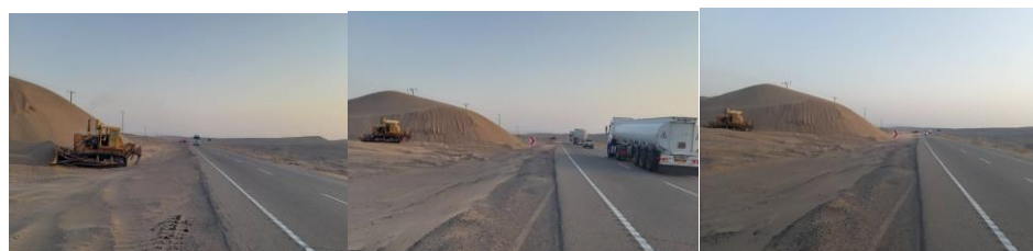
شکل ۱. تهدید جاده توسط ماسه‌های روان و عملیات خاک‌برداری با بولدوزر
