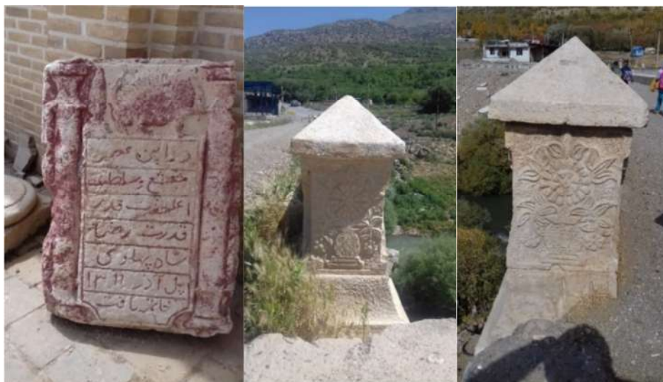
تصویر ۸. تزئینات حجاری و کتیبه پل شماره ۳ کاکارضا/ پل آذر/ رضاشاهی. دید از شرق (مأخذ: نگارندگان).
